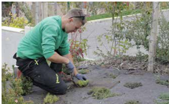
Plantation sur toile de paillage biodégradable
