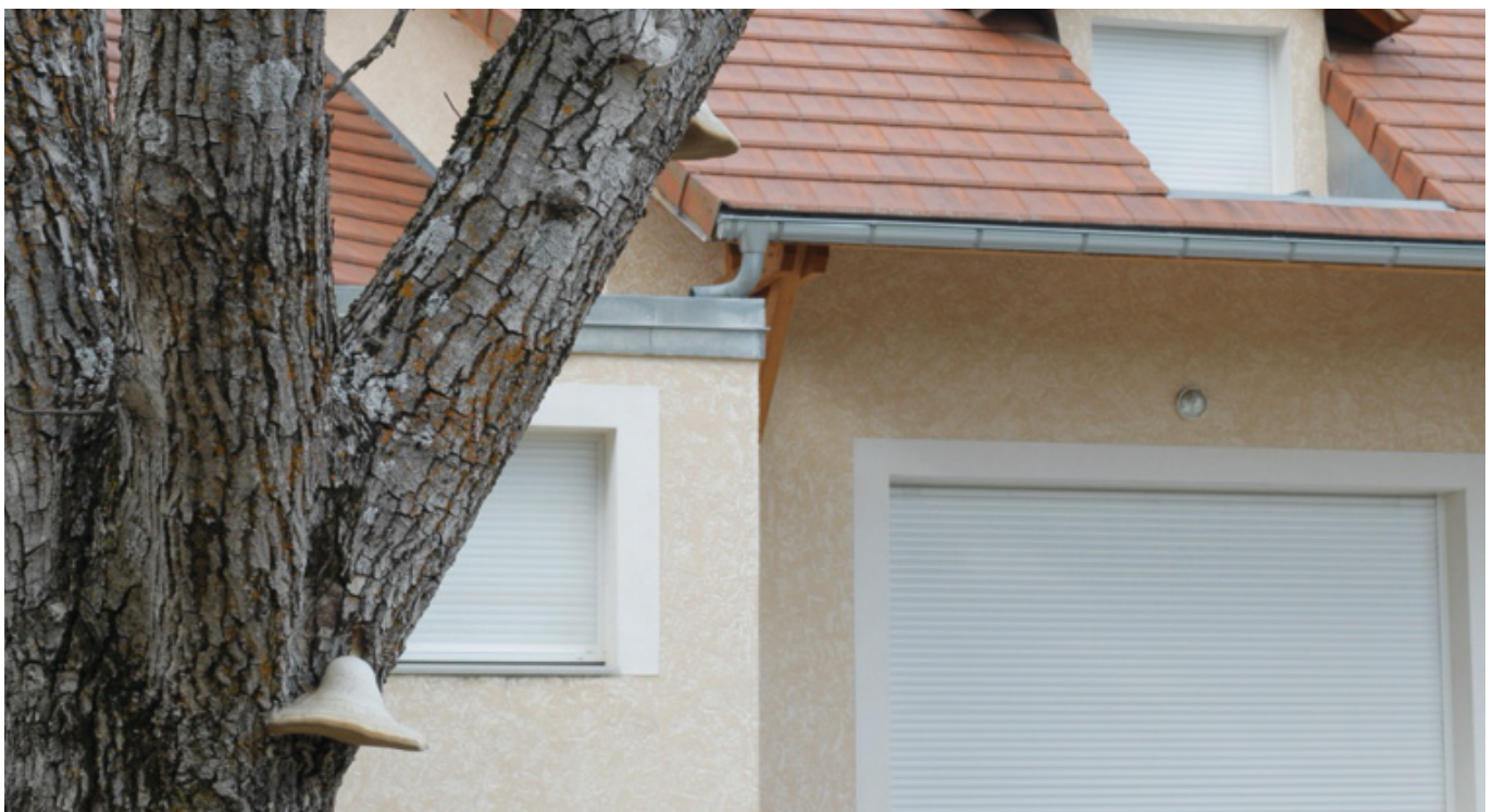
Trois carpophores d'Amadouvier officinal sur un noyer situé à proximité d'une maison, attention danger !
