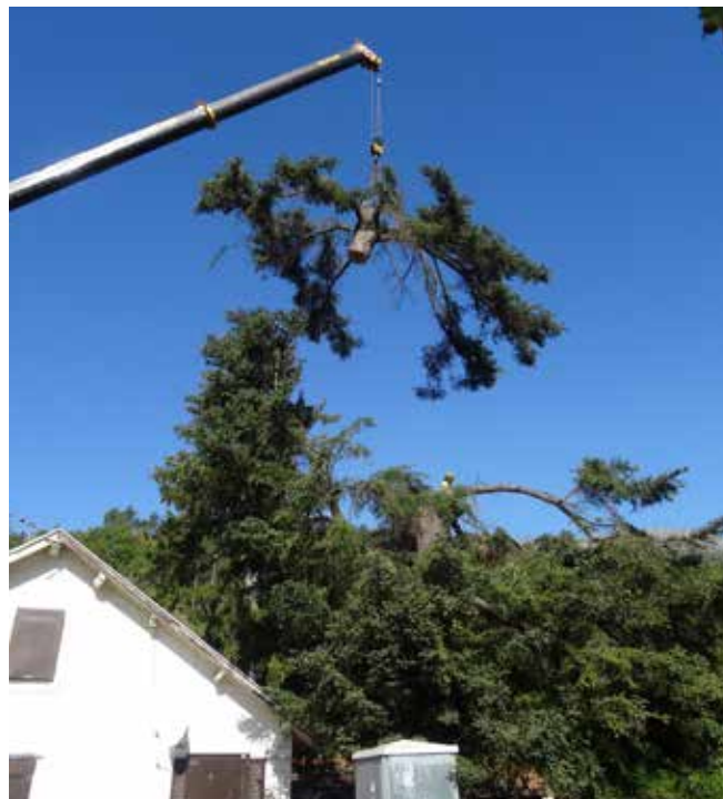
Abattage par démontage avec une grue de levage d'un sapin d'Espagne à Aspres-sur-Buëch
