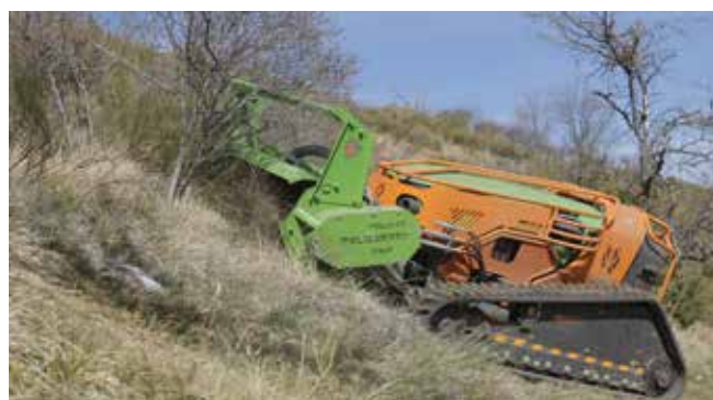
Broyage de végétation arbustive sur pied avec chenillard radiocommandé à Veynes
