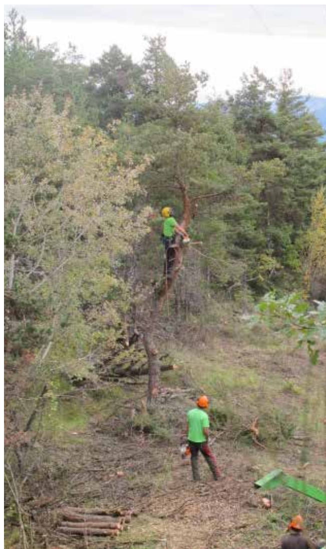
Elagage et abattage aux abords d'ouvrages Enedis 20 kv
