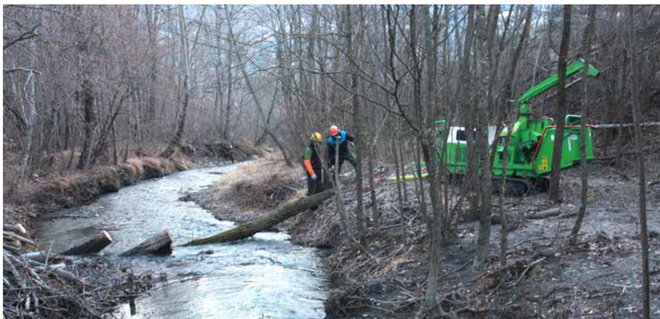
Végétation aux abords d'ouvrages Enedis 20 Kv
